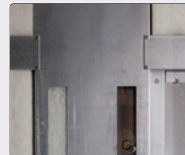
Prečna in vzdolžna ojačitev jeklene konstrukcije - varjeno in kovičeno
